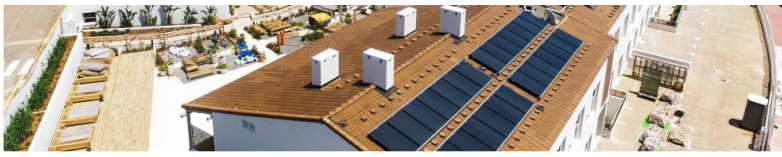
Instalación de paneles solares en un hotel de Menorca. | Abora Solar
