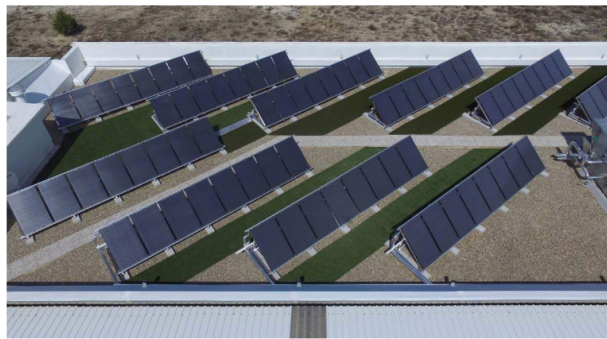
Instalación de paneles solares híbridos de Abora Solar.
