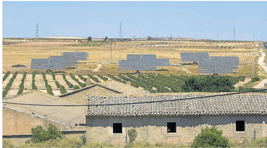
Instalación de placas solares en el campo aragonés.
