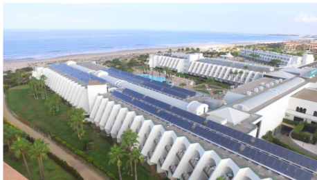
Instalación de los paneles solares híbridos de Abora Solar en un hotel
