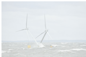
El prototipo de plataforma flotante de dos turbinas Nezy2 supera las pruebas en el
